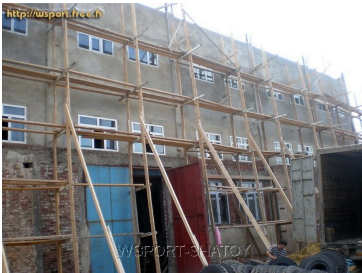
Строительство нового комплекса Школы им. братьев Сайтиевых
