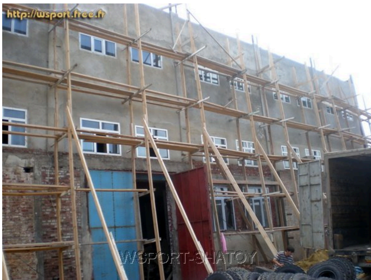
Строительство нового комплекса Школы им. братьев Сайтиевых
